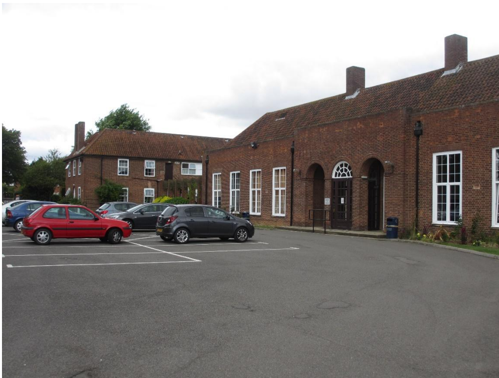
ABBILDUNG 1 EINGANGSBEREICH LANCHASTER HALL
