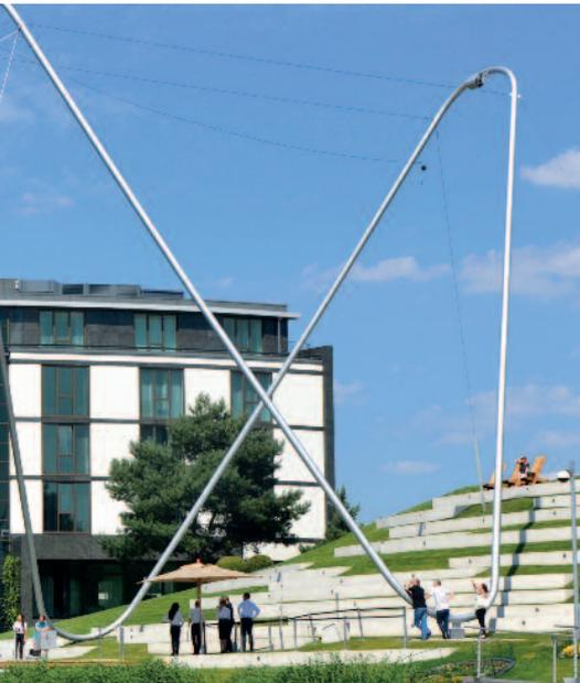
Aussteigen. Sie wird nach unten geschwenkt, um die notwendige Beinfreiheit während des Betriebs zu erhalten. Die Himmelsschaukel HS 20 wurde nach den Richtlinien für den Bau und Betrieb „Fliegender Bauten“ erstellt.
