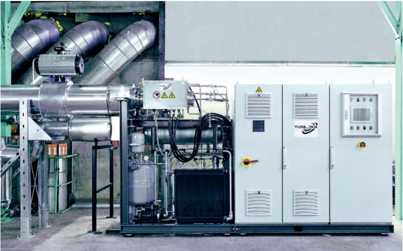
Durch die Direktkopplung von Turbine und Generator im Zusammenspiel mit einem optimierten Laufraddesign erreicht die Mikro-Dampfturbine einen bis zu 40 % höheren Wirkungsgrad als bisherige Turbinen in ihrem Leistungsbereich. Somit ermöglicht die Mikro-Dampfturbine einen wirtschaftlichen Betrieb auch bei kleinen Anlagen.
